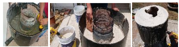
Figura 6. Rehabilitación y mantenimiento del horno.
